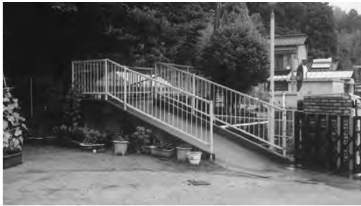
平成23年5月 高山工業所 様 ●園庭敷地内に橋を作っていただいた。
