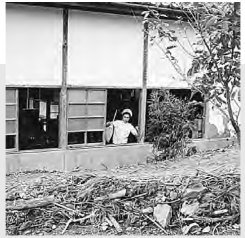
台風で土砂が園舎に 流れ込む（昭和41年）
