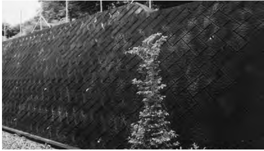
平成20年9月 高山工業所 様 ●園舎裏側の土留め壁工事
